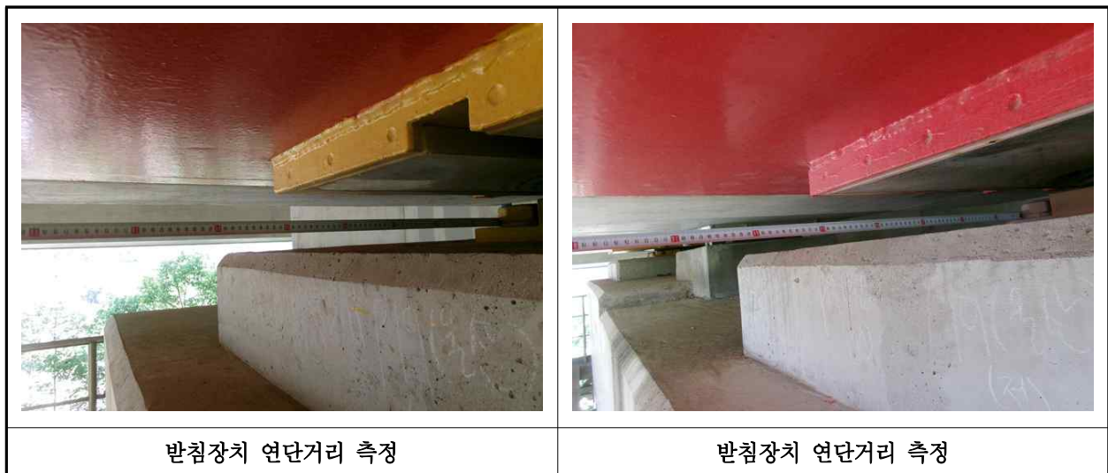
【사진 46.3.19】 교량받침장치 연단거리측정
