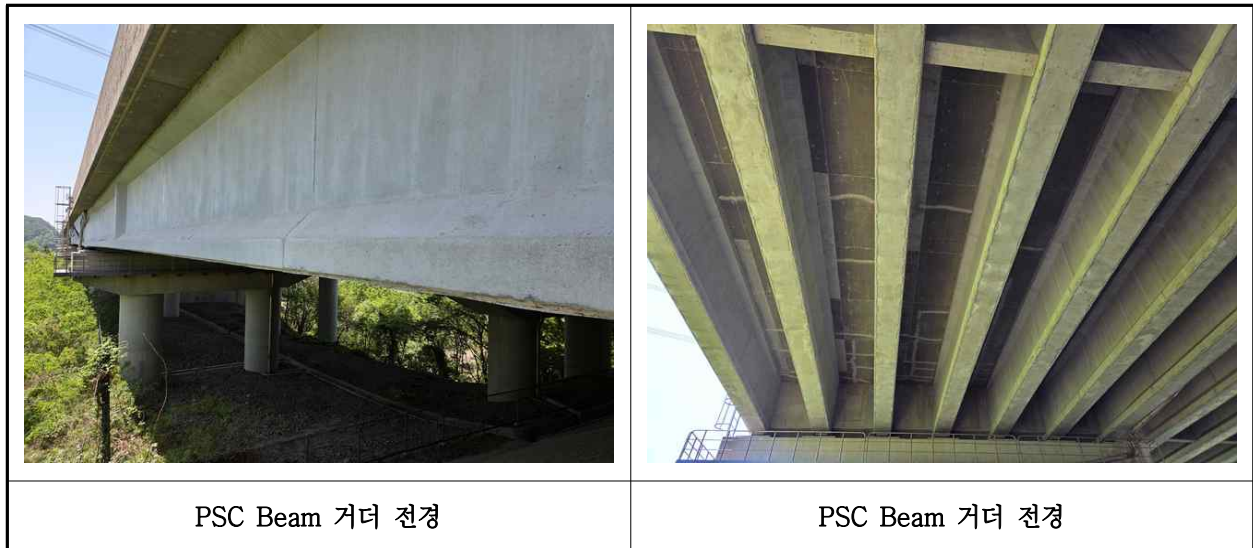
【사진 46.3.8】 PSC Beam 거더 전경
