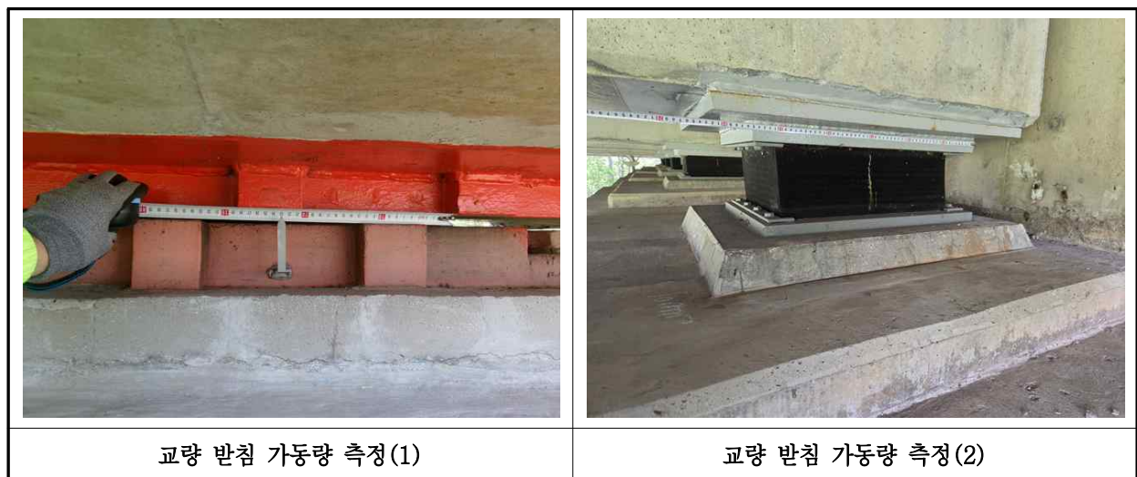
【사진 46.3.20】교량받침 이동량 측정
