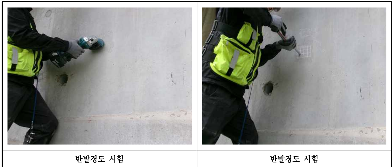
【사진 46.4.2】 반발경도시험 현장사진
