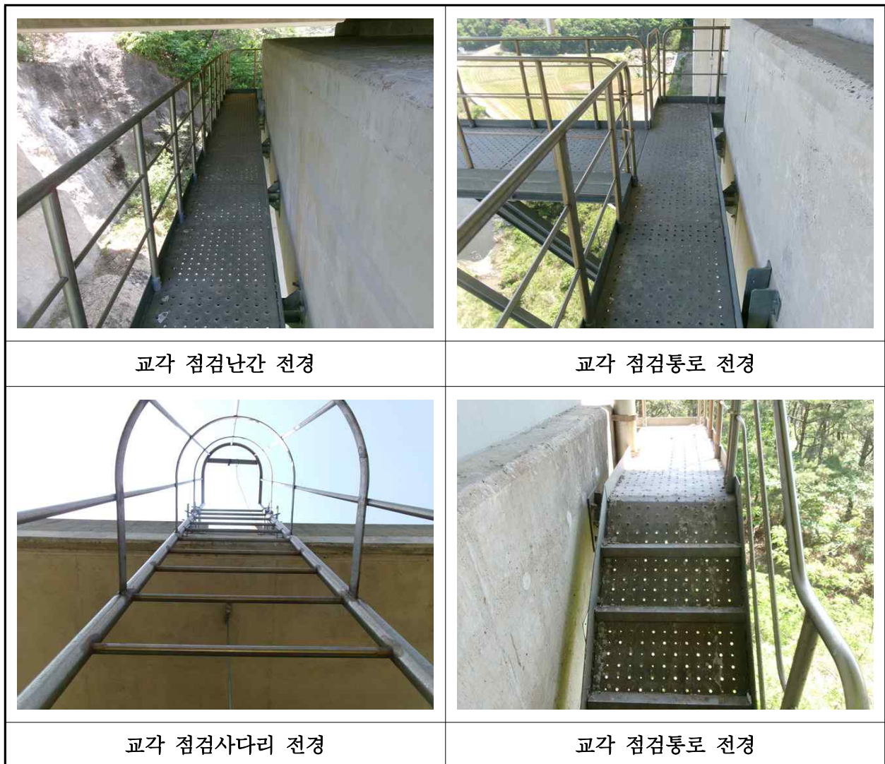
【사진 46.3.30】 교량 점검시설 전경
