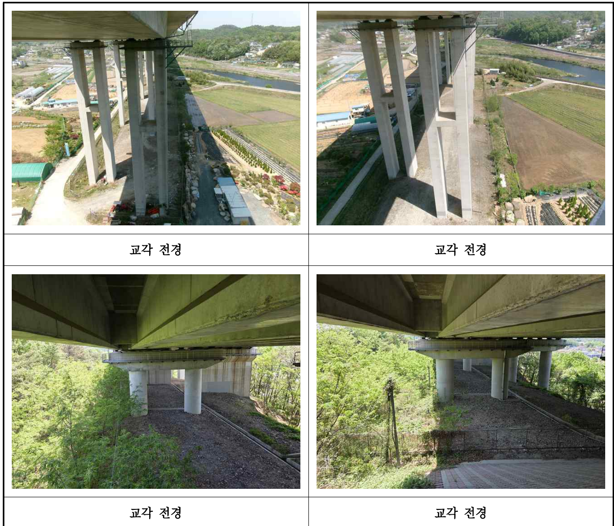
【사진 46.3.14】 교각 전경
