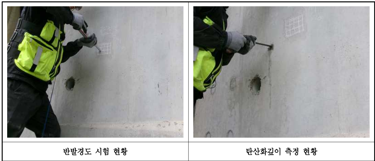
【사진 46.4.1】 콘크리트 내구성조사 현황
