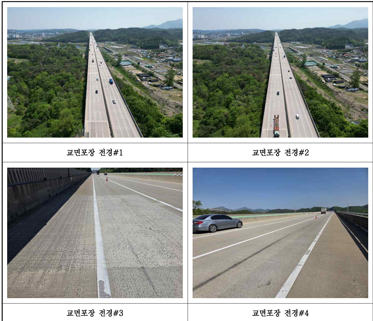
【사진 46.3.24】 교면포장 전경
