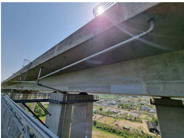
교량 배수관 상태양호
