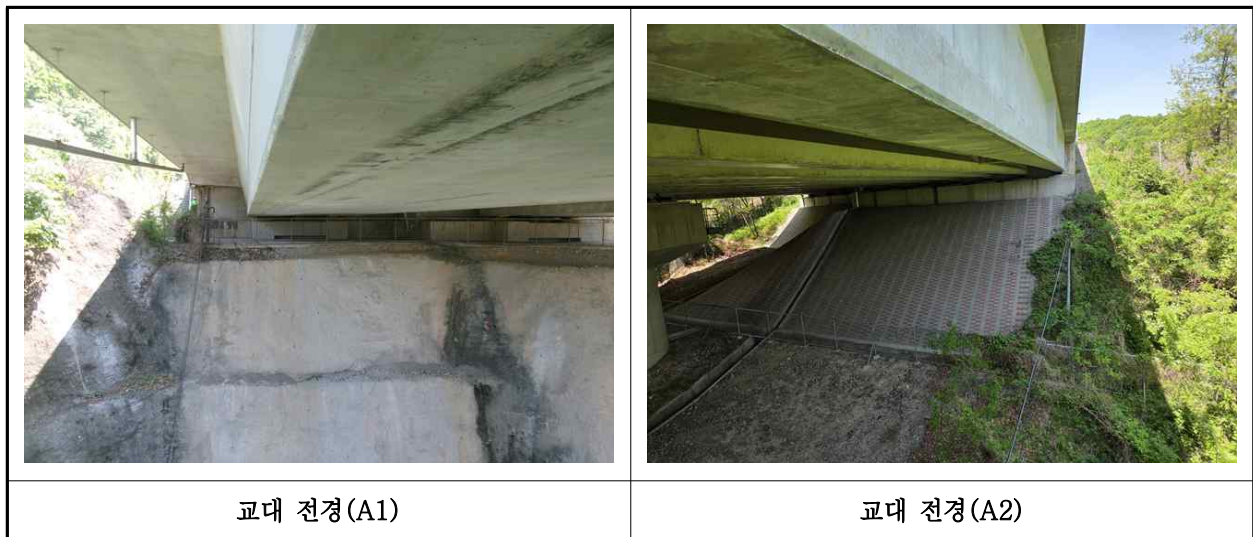
【사진 46.3.12】 교대 전경
