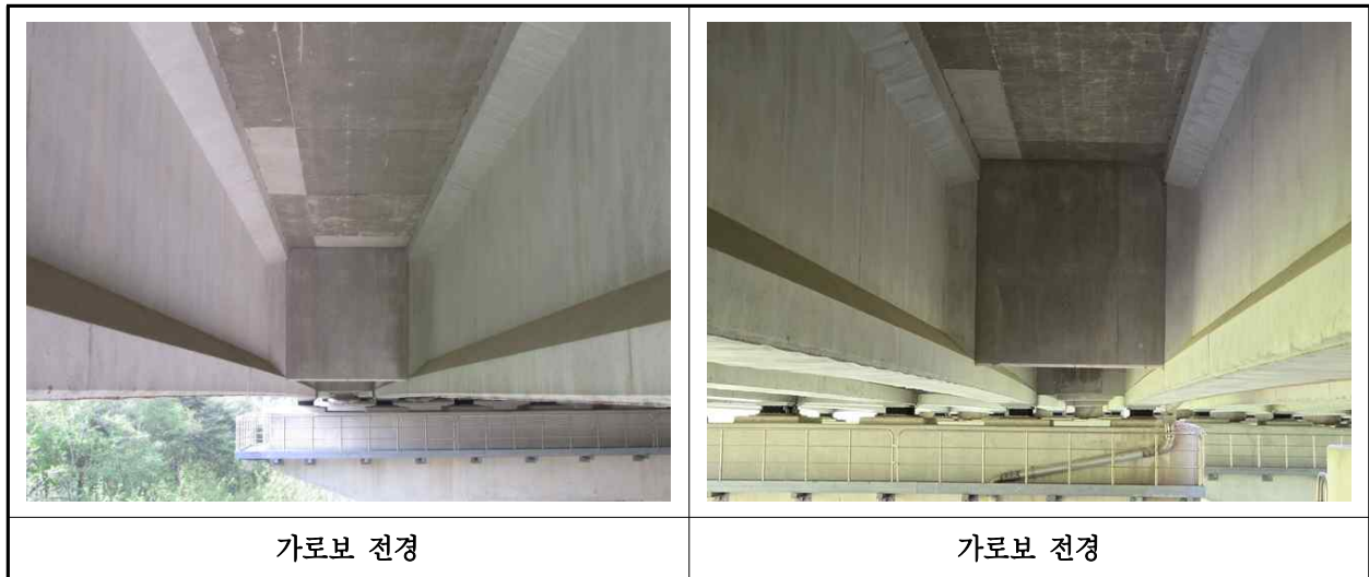
【사진 46.3.10】 가로보 전경
