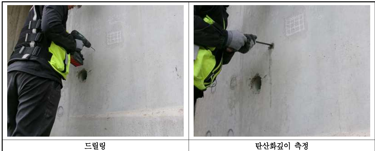
【사진 46.4.3】 탄산화 깊이 측정 현장사진
